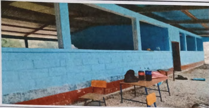
Foto 1: proceso de fase intermedio de pintada de pared e instalacion de balcones y puertas del modulo I.
