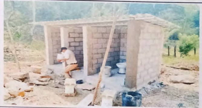
Foto 4: proceso de levantado de pared, techado e instalacion de inodoro del baño, modulo IV.
