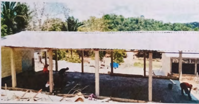
Foto 3: fase intermedio de techado y fundicion de piso del modulo III
